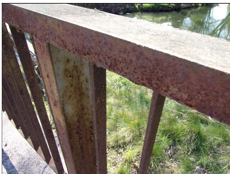
Povrchová koroze zábradlí
