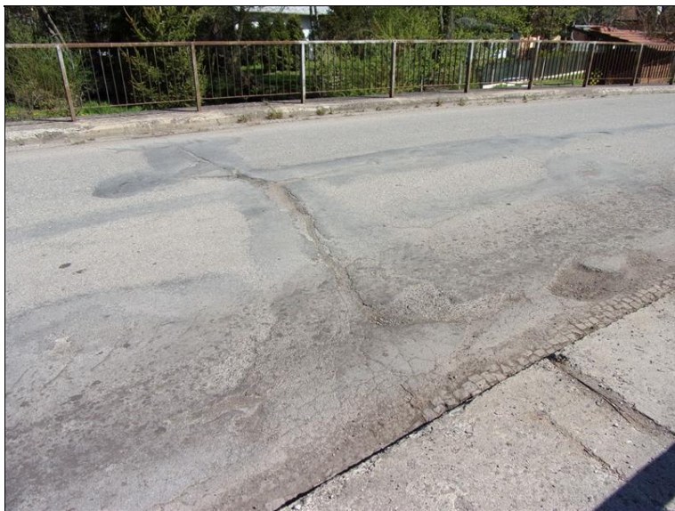
Trhlina ve vozovce v místě dilatace
