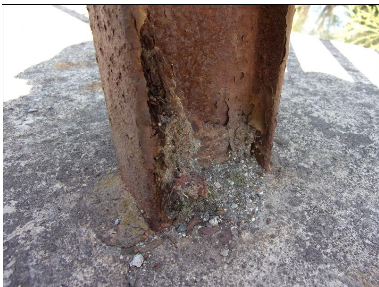
Koroze v patě sloupku zábradlí
